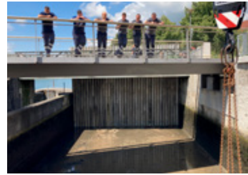
Der Kanal zum Maschinenhaus ist trockengelegt.
