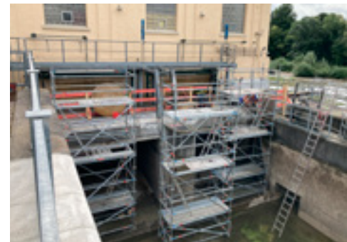
Abbau der alten Rechenanlage, die Schwemmgut von den Turbinen fernhielt.
