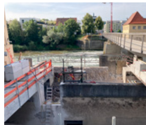
Die Rinne der Fischtreppe wird leergeräumt, Steine und Substrat werden gereinigt.
