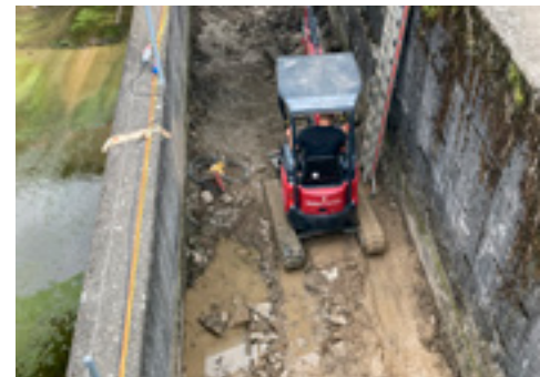
Die Rinne der Fischtreppe wird leergeräumt, Steine und Substrat werden gereinigt.
