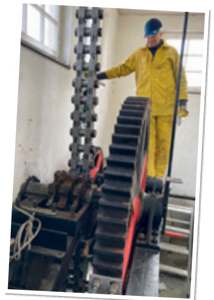
Kettentausch an der Wehrwalze. Die Zahnräder sind seit mehr als 110 Jahren im Einsatz.
