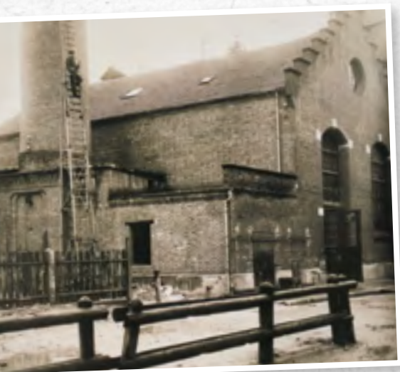
Erstes Tübinger Elektrizitätswerk 1902 in der Nonnengasse. Im Inneren wummern die Dampfmaschinen, direkt daneben entsteht die Verwaltung der städtischen Werke. Heute ist hier die Stadtbücherei zu Hause.
