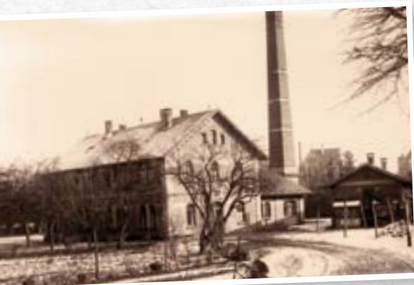
Das Wasserwerk besteht aus einem acht Meter tiefen Grundwasserbrunnen und einer dampfgetriebenen Pumpe, die das Wasser in einen Hochbehälter auf dem Österberg pumpt.
