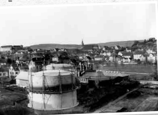
1862 ist das städtische Gaswerk das erste Gebäude südlich der Bahnlinie, hier mit dem neuen Gasometer von 1898.
