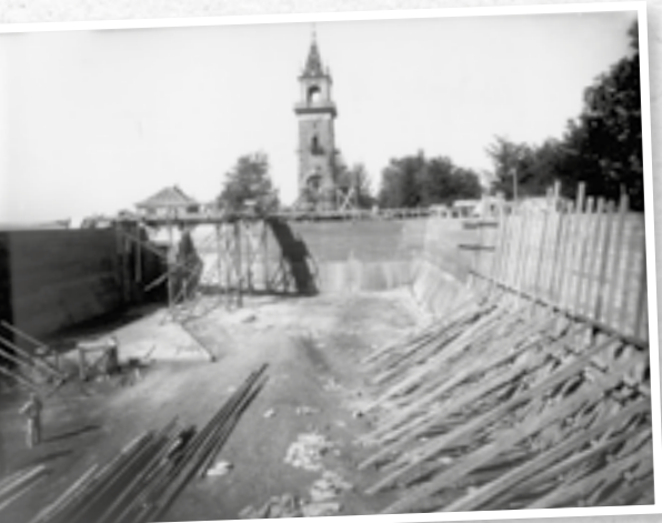
Neben dem Kaiser-Wilhelm-Turm auf dem Österberg wird 1922 das Reservoir für ein fortschrittliches Pumpspeicherkraftwerk gebaut, das bis 1945 Strom liefert.
